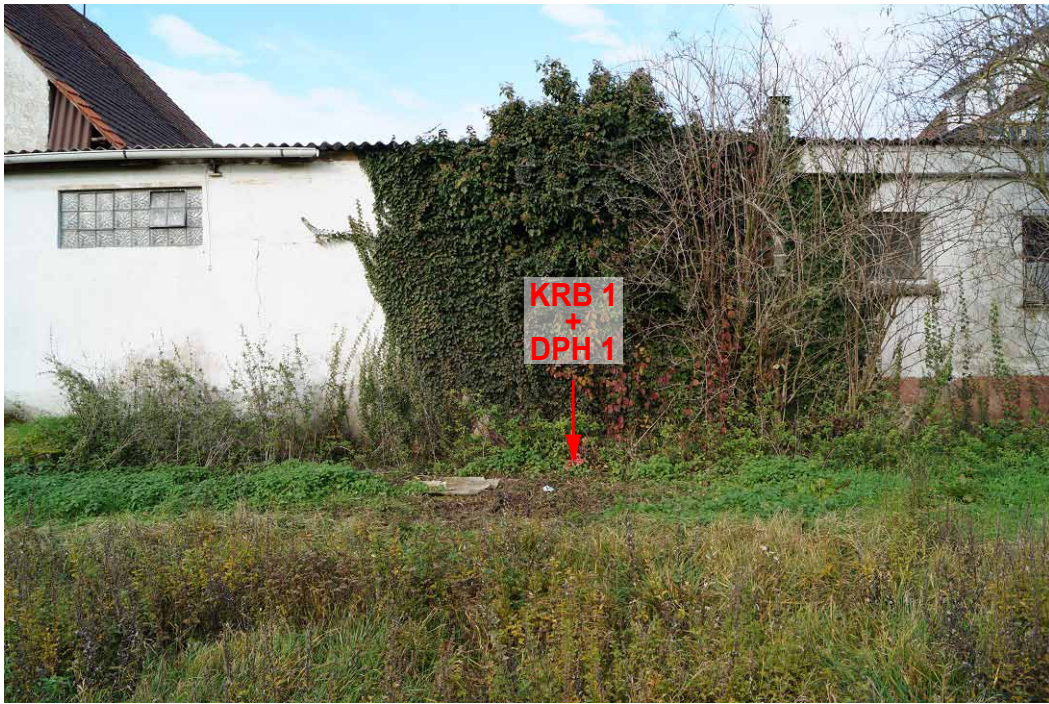
Bild 1: Lage von KRB 1 + DPH 1 (Blickrichtung NW) (23.11.2017)
