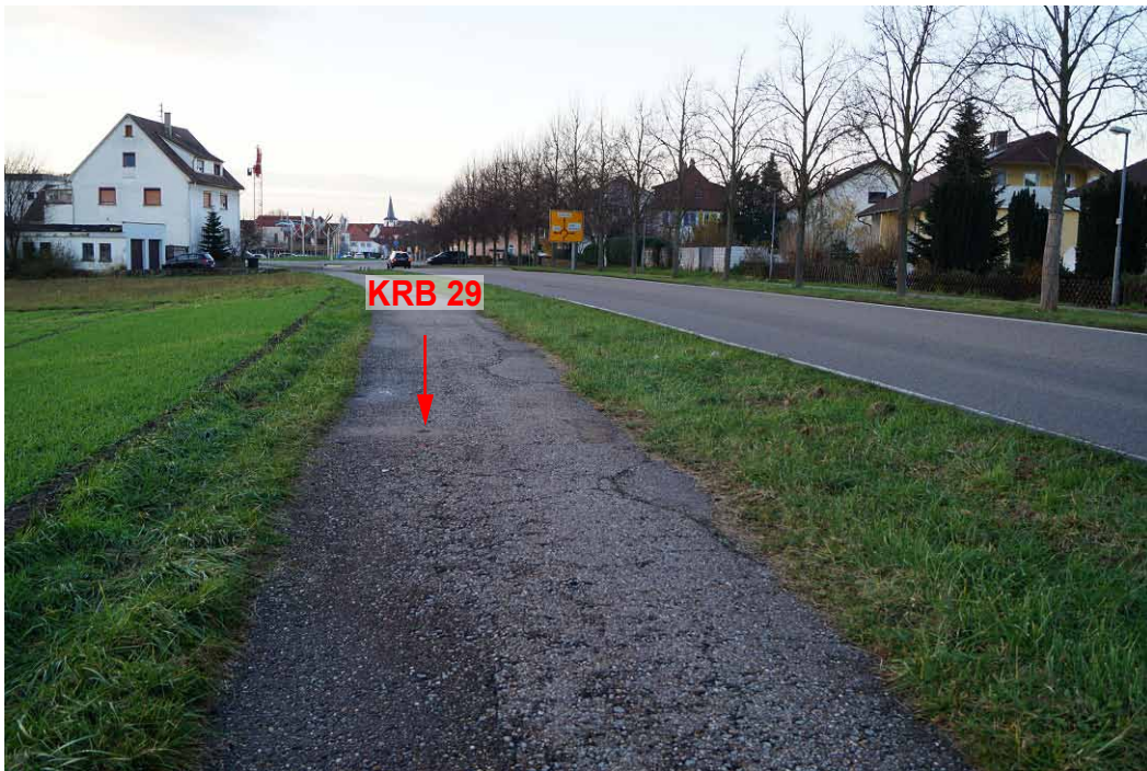
Bild 25: Lage von KRB 29 (Blickrichtung NW) (29.11.2017)
