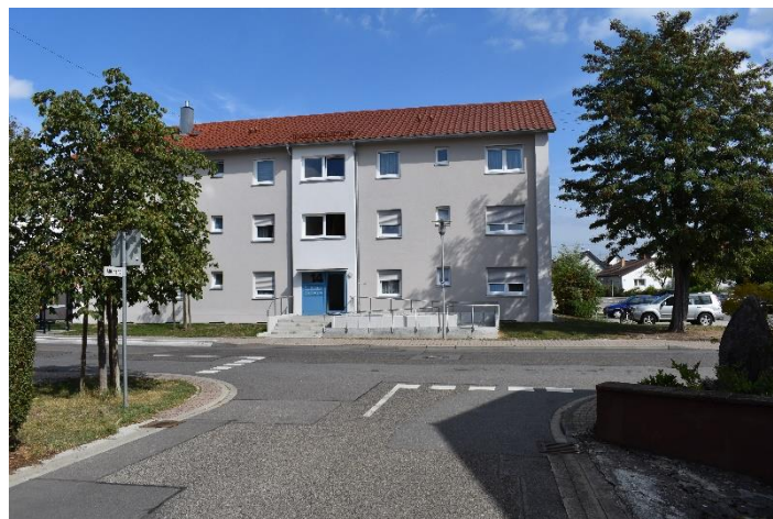
Sambugaweg 14 (Sanierung mit Pelletheizung)
